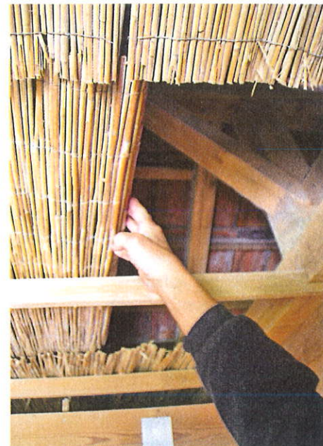
Die Zwischendecke im Taubenschlag besteht aus ausgerollten Schilfmatten, die einmal jährlich gereinigt werden
